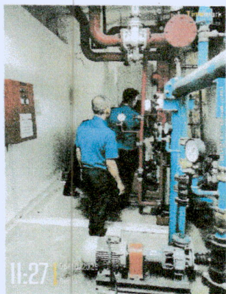
Pemeriksaan pompa Hydrant
